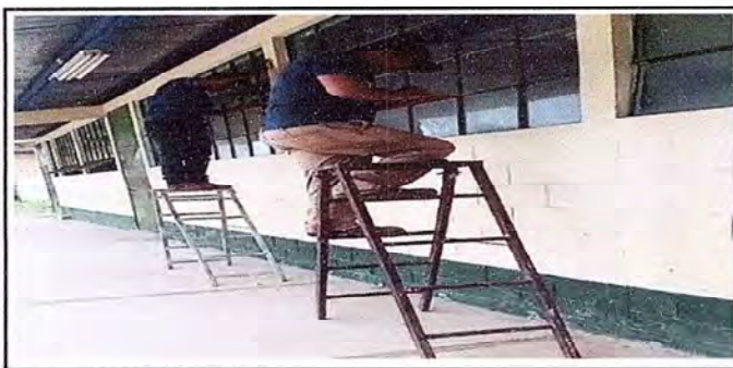
Foto 5: Colocación de balcón
