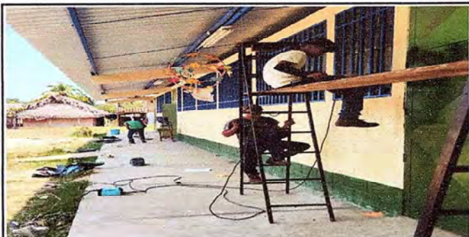
Foto 3: Colocación de balcones
