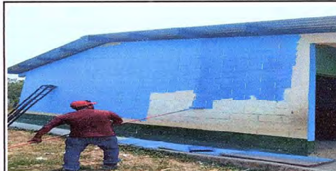
Foto 4: Restauración de pintura en muro exterior de aulas
