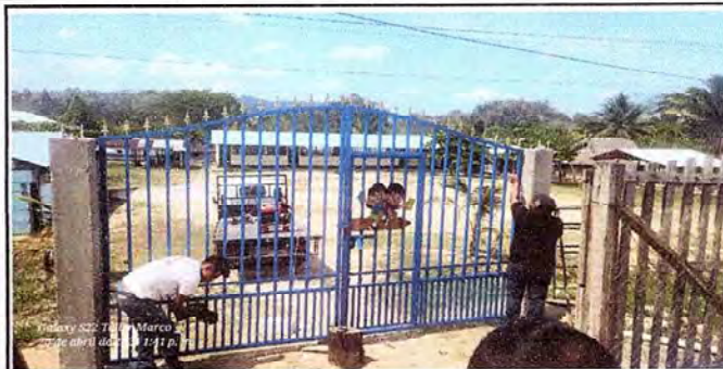
Foto 2: Colocación del portón principal.
